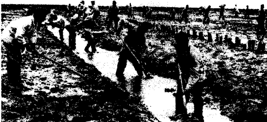
Reichsarbeitsdienst beim Trockenlegen eines Sumpfes
